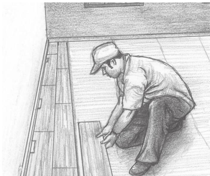
**Figura 4:** Instalação do piso laminado
